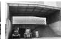
③屋外置場の屋根設置
