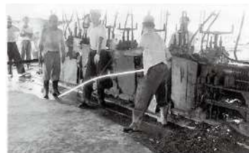
第一伸鉄工場の作業風景
