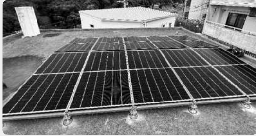
花城宅屋上に設置された20枚の太陽光パネル【完成後】
