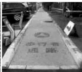
再生スラグを使用した「タクナンロード」を施工
