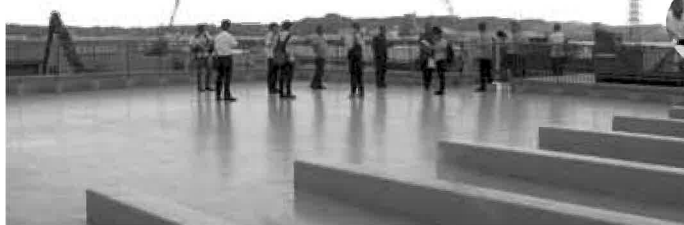
屋上階の津波避難施設
