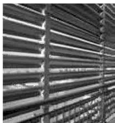
外観2階部の鋼製ルーバー
