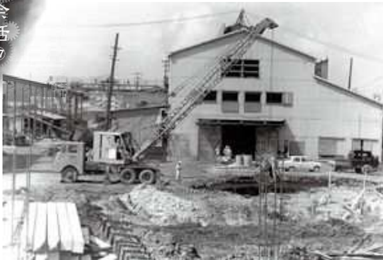
20トン炉リプレス工場建設現場※正面が旧製鋼工場
